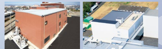
治験原薬製造棟 小田原総合製剤工場内の高生理活性固形製剤棟
